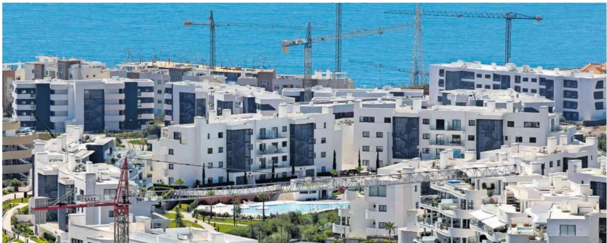
Edificios en construcción con piscina en Benalmádena. GARCÍA-SANTOS
